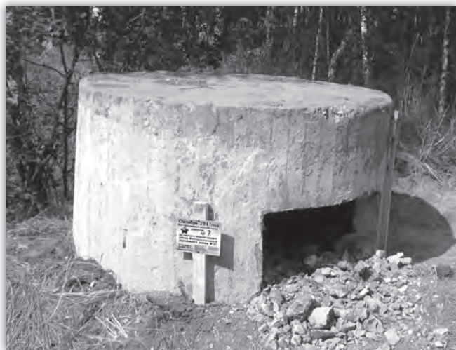
ДОТ № 7 после перевозки
